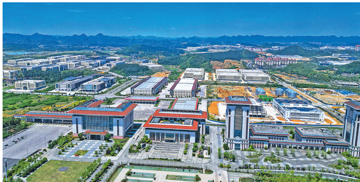
俯瞰贵安综合保税区(5月20日报)。 贵阳日报融媒体中心记者 石照昌 摄
