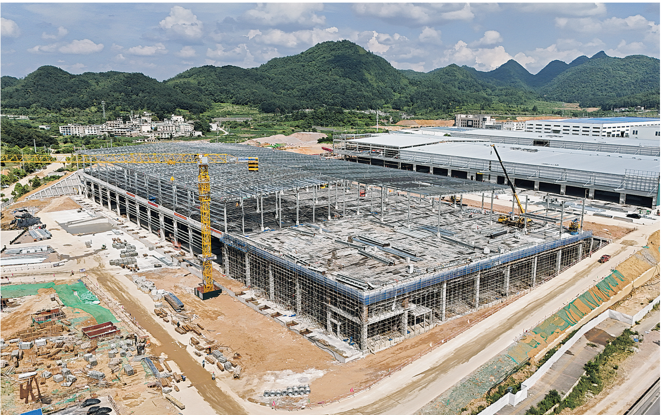
美宜佳(贵州)产业园项目施工现场。
