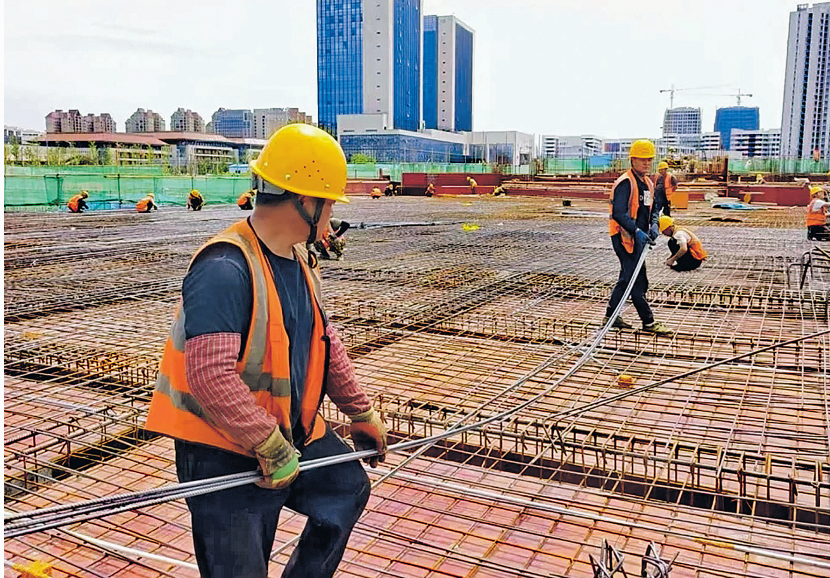
贵安新区人工智能人才保障性租赁住房项目建设现场。
