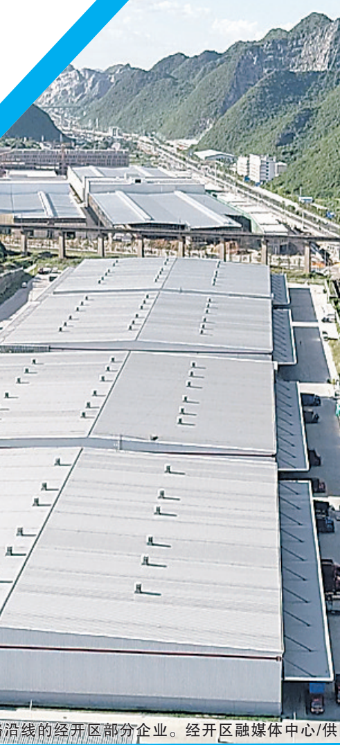
俯瞰龙冠路沿线的经开区部分企业。经开区融媒体中心/供图
