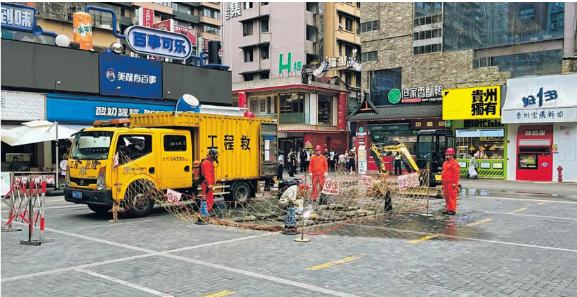
演练中，贵州燃气集团专业燃气抢险队伍模拟对破损管道进行抢修。
