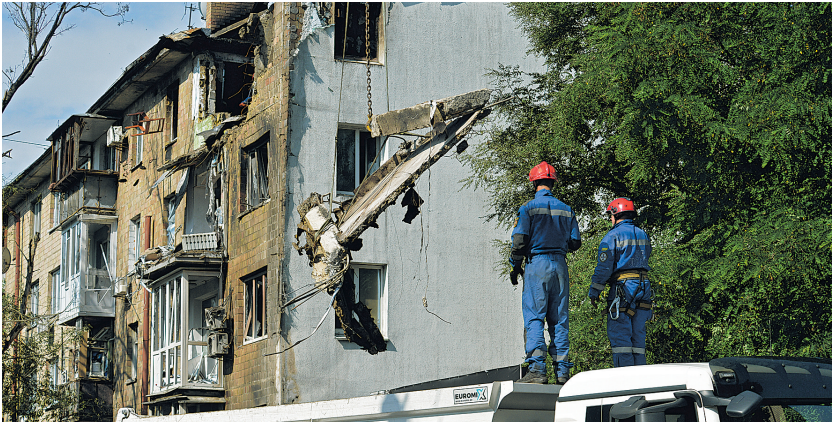
7月10日,在乌克兰基辅市舍甫琴科夫斯基区,救援人员拆除在空袭中受损的居民楼。
