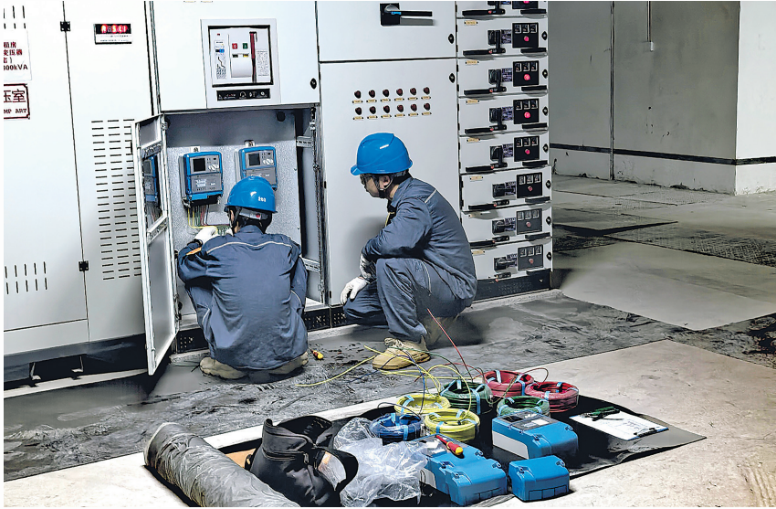
贵安供电局工作人员在贵安新区高端装备制造产业园南部公租房的配电房更换电表。
