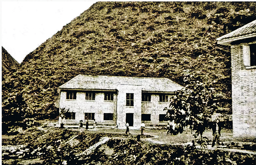
1940年7月29日,日机向花溪丢下五枚炸弹,其中一枚落在清华中学南北楼之间,炸出约5米宽、3米深的弹坑。贵阳市清华中学/供图
