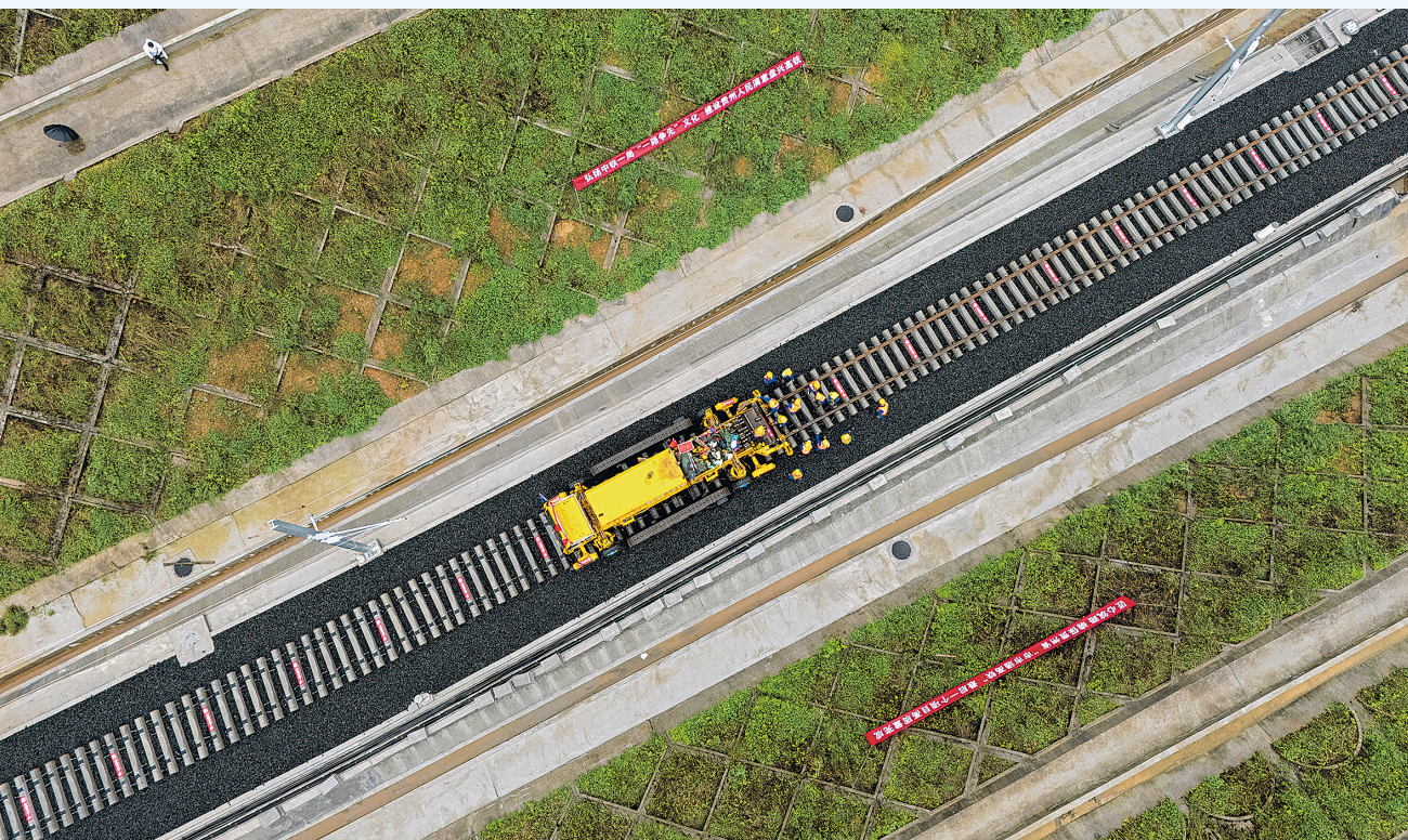
7月22日,中铁一局建设者在盘兴高铁接轨处进行铺轨施工(无人机照片)。 新华/传真
