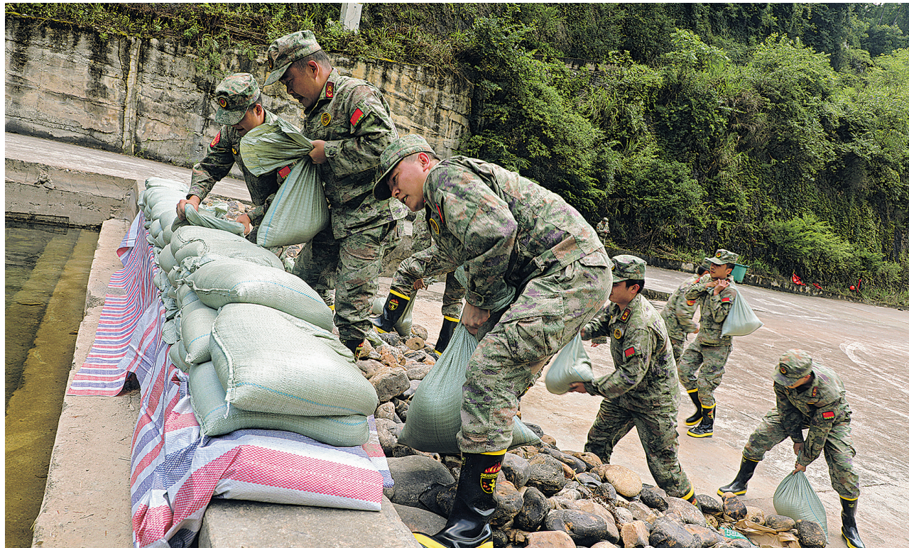
演练队伍进行囤堤排险。
