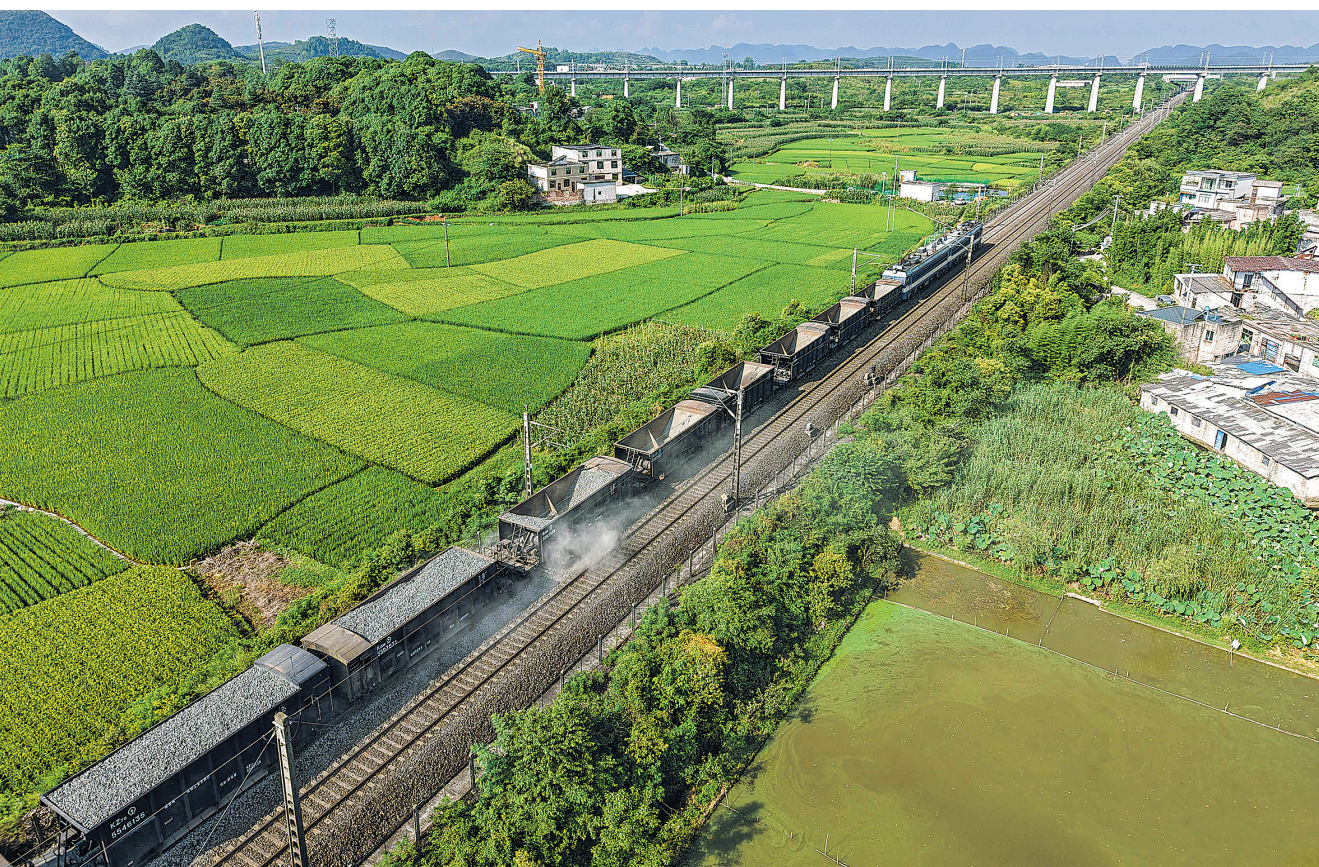
8月1日,工作人员在湖潮站至马场站区间进行大修作业(无人机照片)。新华/传真
