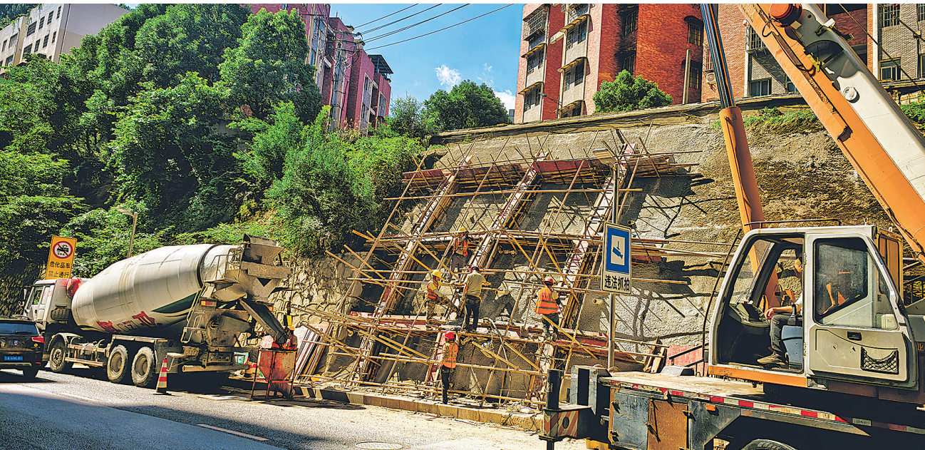
正在修复中的干平路挡土墙。
