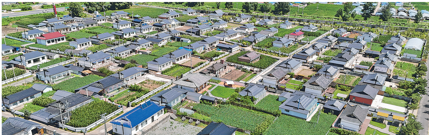
在吉林省和龙市光东村拍摄的特色民居群(2025年7月18日,无人机照片)。
