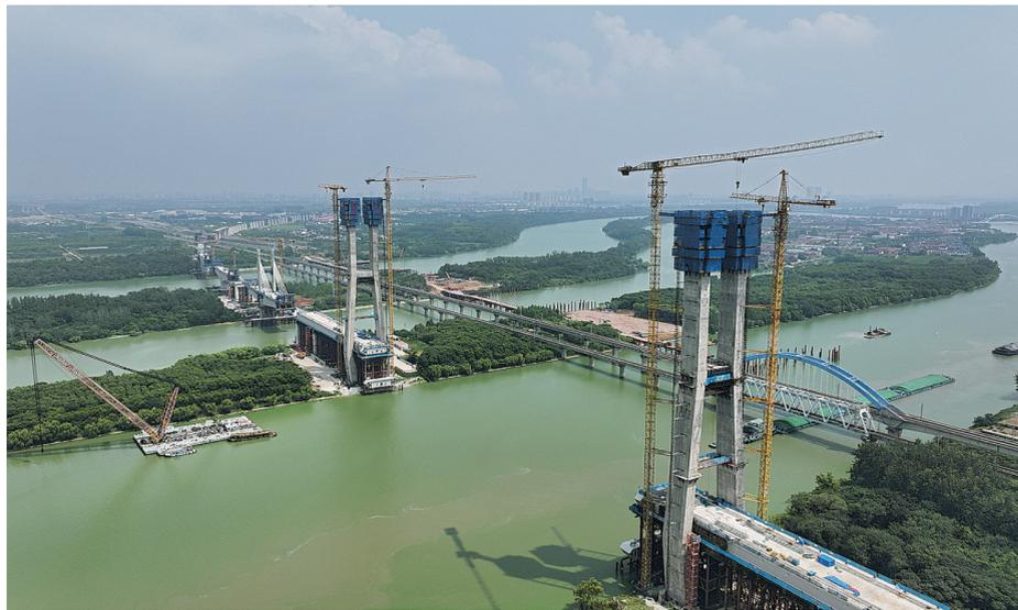
8月5日,由中国铁建大桥局承建的沪渝蓉高铁跨京杭运河斜拉桥主塔顺利封顶。至此,大桥核心支撑结构施工圆满收官,项目全面转入钢梁及斜拉索安装新阶段。该桥位于江苏扬州境内,是沪渝蓉高铁全线关键控制性工程,桥长564.3米,主跨300米。沪渝蓉高铁是国家“八纵八横”高铁骨干通道之一,线路总长约2100公里,设计时速350公里。
