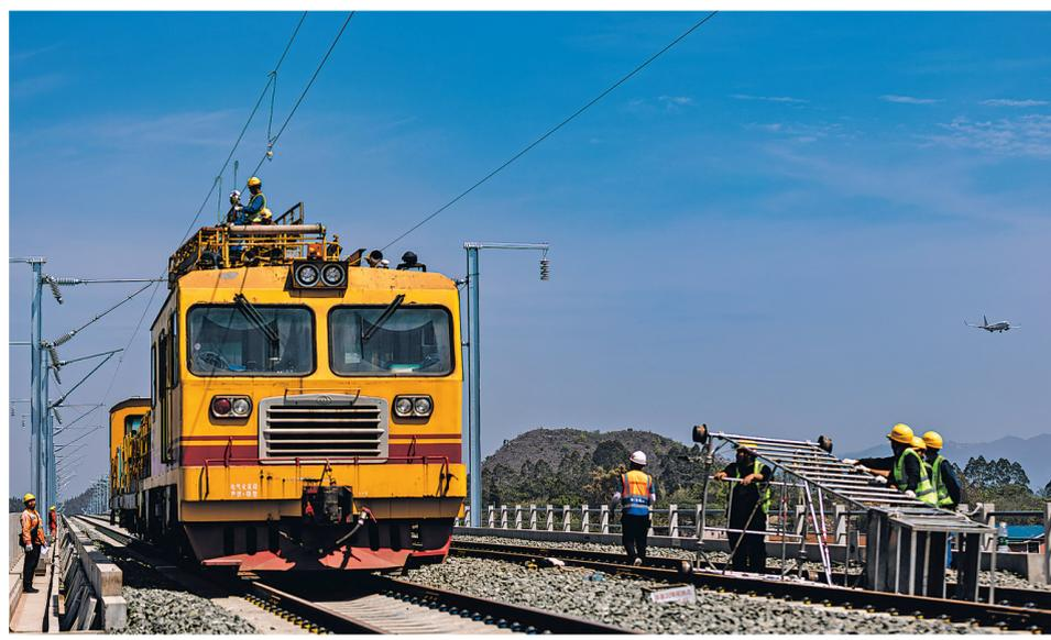
8月6日,工人在盘兴高铁兴义南站附近架设接触网。国铁成都局集团公司/供图
