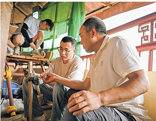
牟常有(右一)在麦积山石窟157窟前指导徒弟李浩亮制作用于塑像修复的木骨架。
