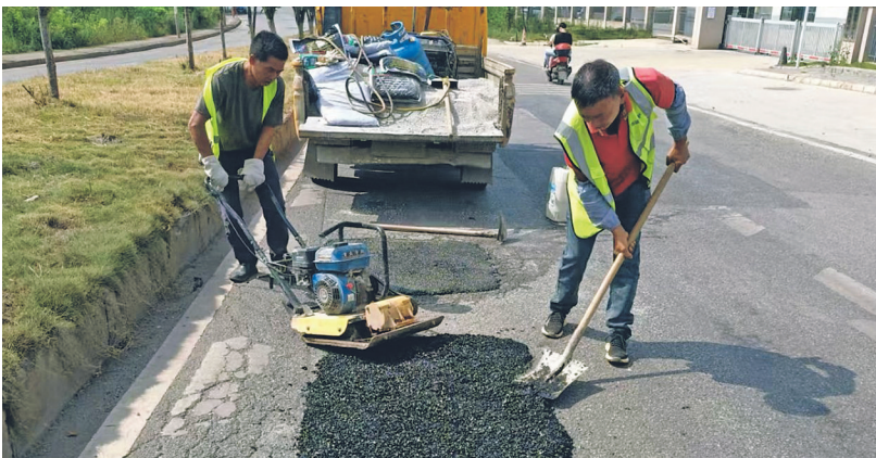
工人对破损路面进行修复。
