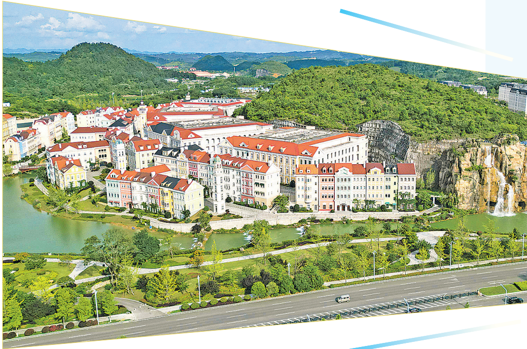
贵安华为云数据中心一角。
