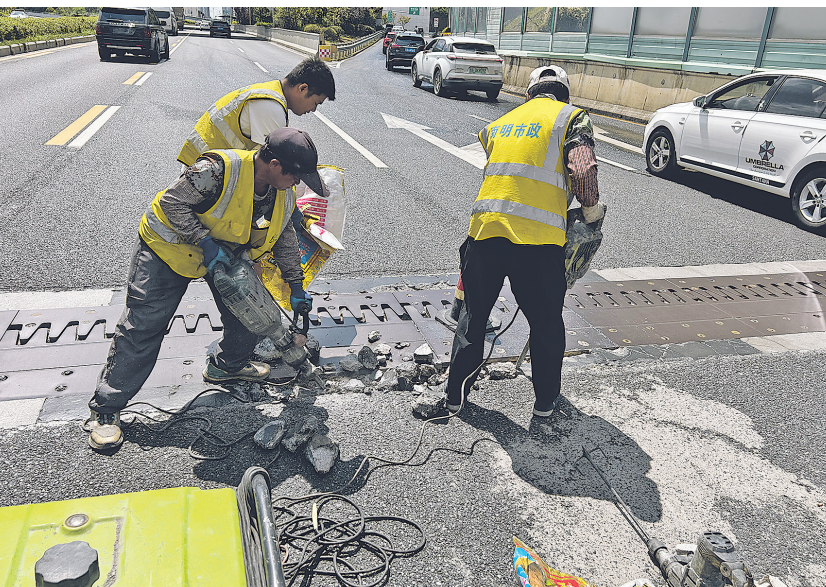
工作人员在修复桥梁伸缩缝。
