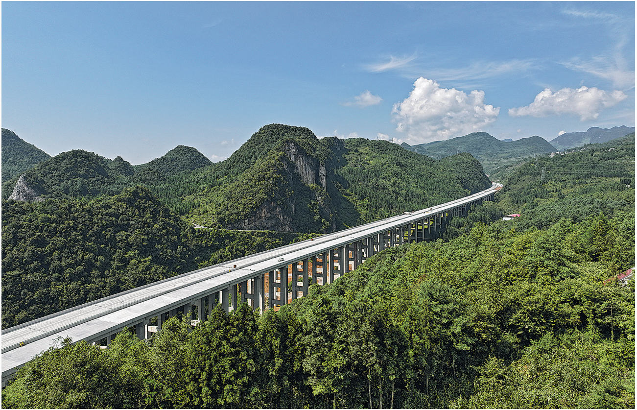
俯瞰安盘高速百石养特大桥。
