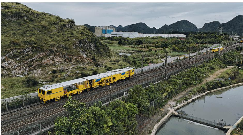
9月28日，贵阳工务段在沪昆铁路平坝站开展道岔大机捣固作业。
