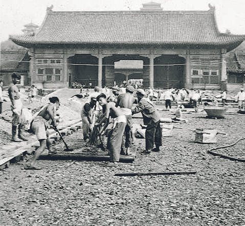
不断修缮让故宫生命永续,这是工人们在维修北上门(1956年拆除)内地面。
