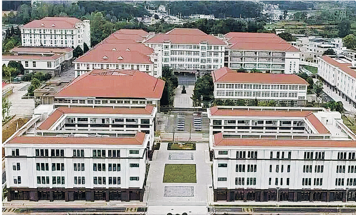
俯瞰贵安新区实验中学高中部教学楼项目。
