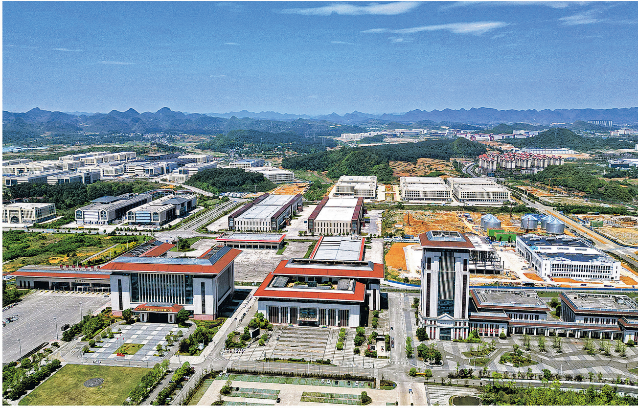
俯瞰贵安综保区。 贵阳日报融媒体中心记者 石照昌 摄
