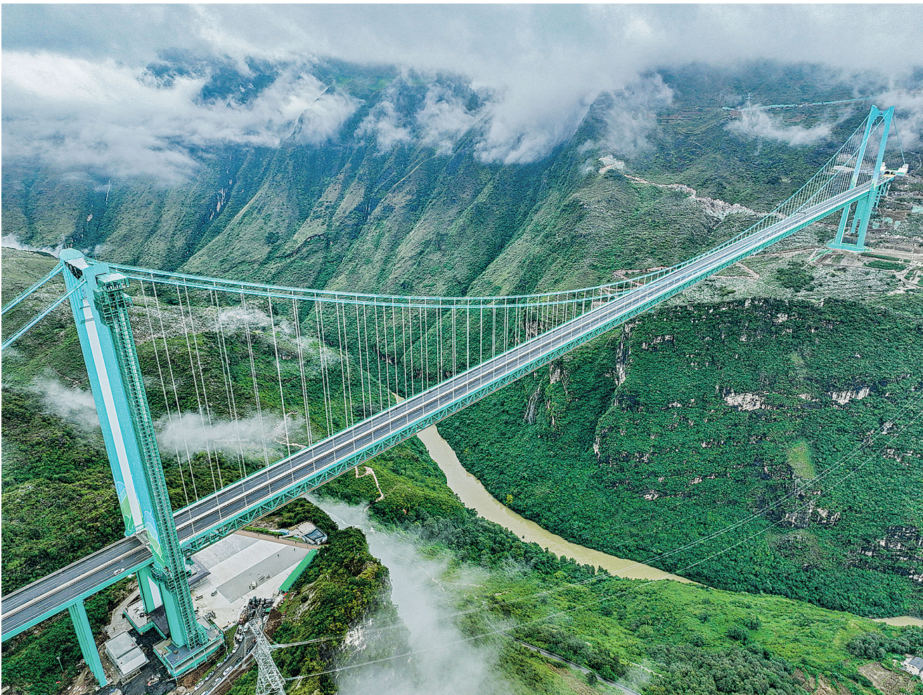
9月26日拍摄的贵州花江峡谷大桥(无人机照片)。 新华/传真
