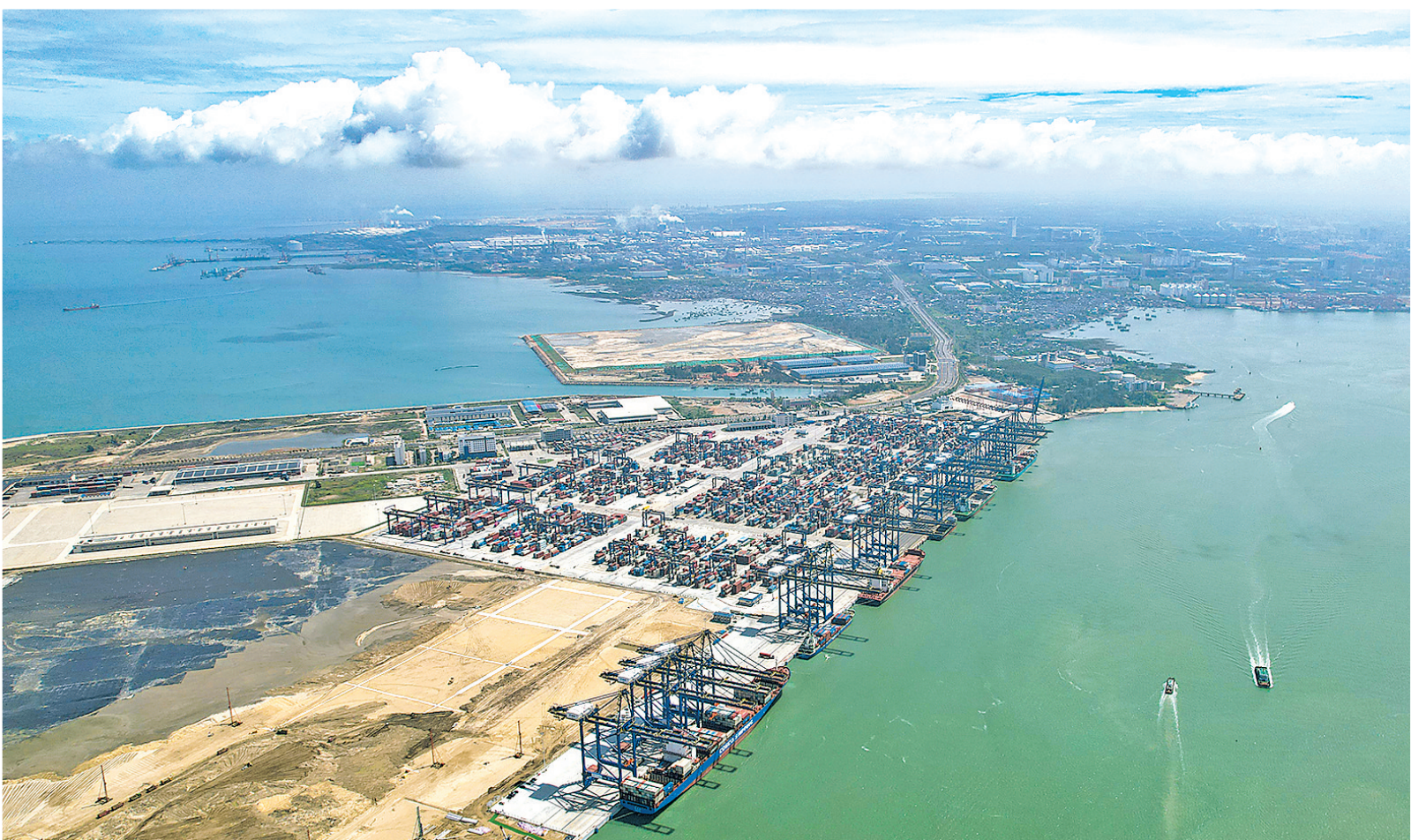
海南洋浦国际集装箱码头(5月28日摄,无人机照片)。
