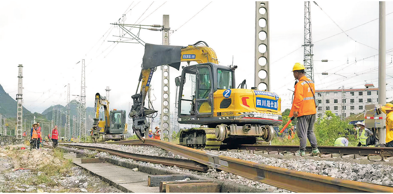
工作人员在施工现场作业。
