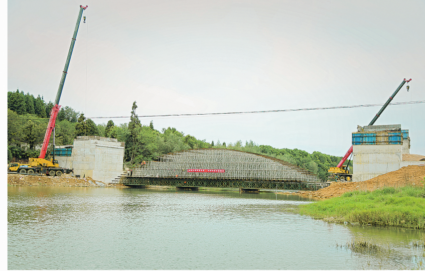
正在修建的红旗桥。
