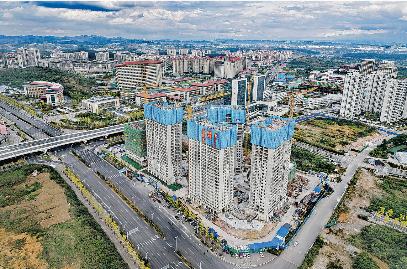
俯瞰贵安新区人工智能人才保障性租赁住房项目。
