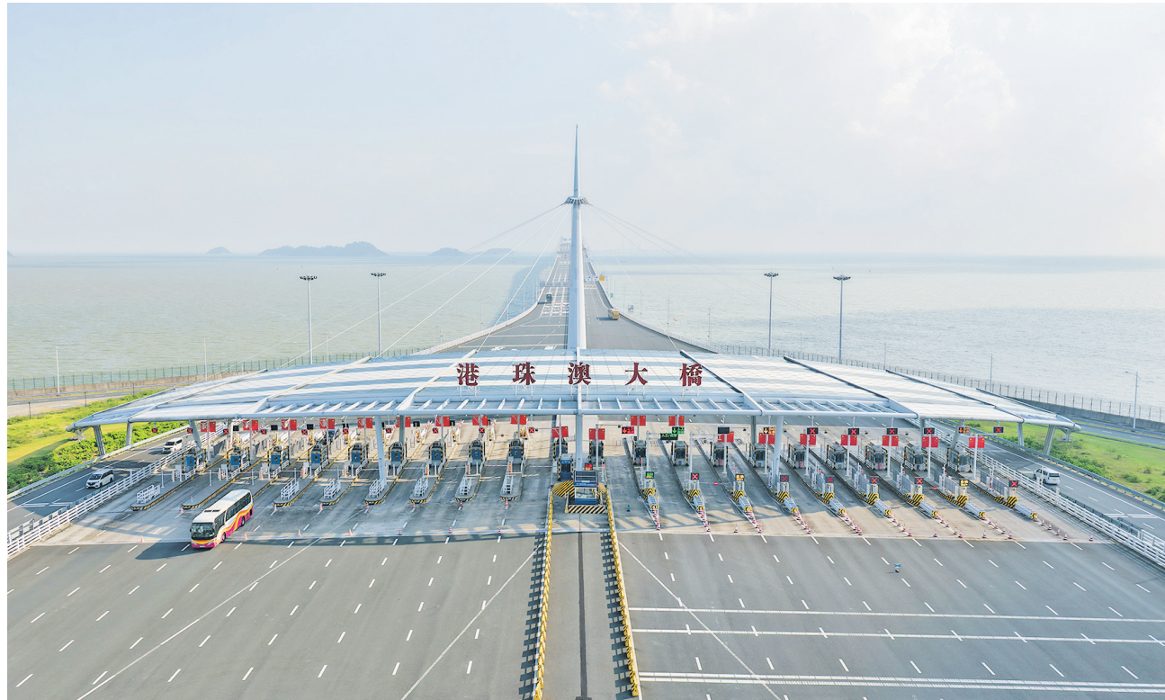
10月19日拍摄的港珠澳大桥入口（无人机照片）。 新华/传真
