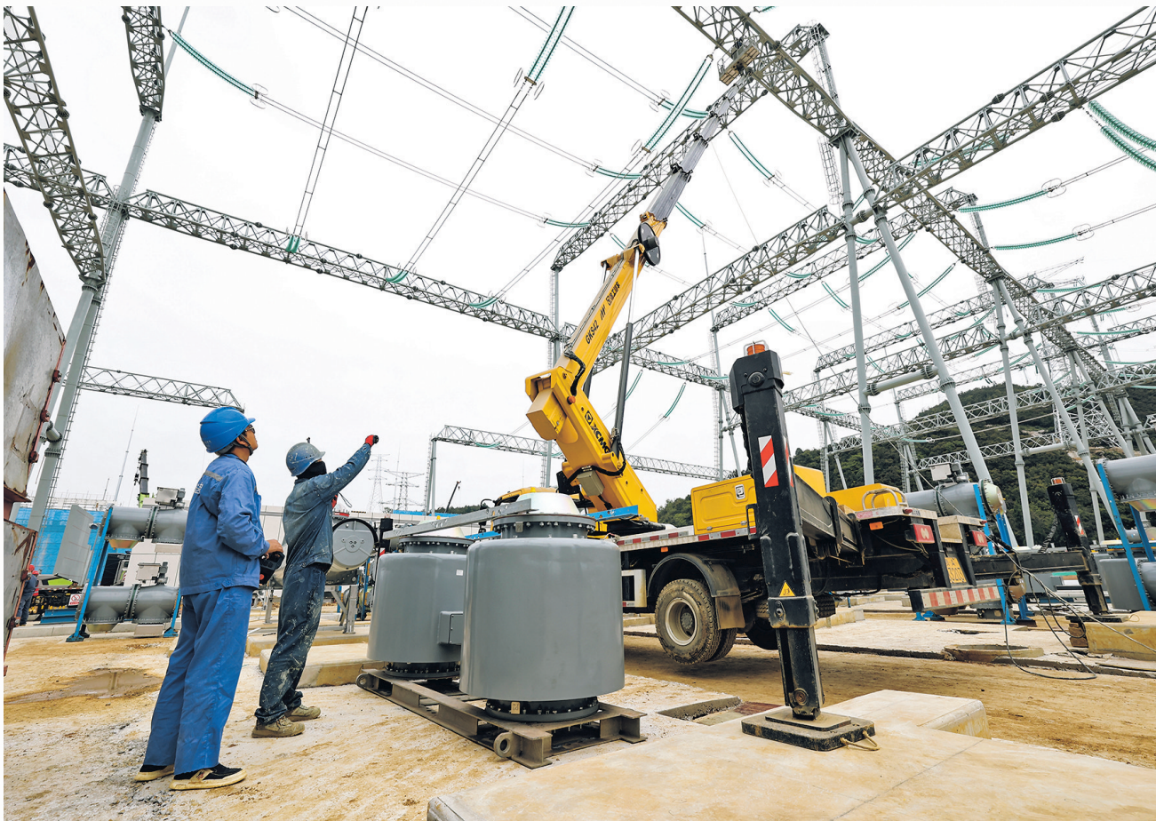
工作人员在500千伏马场变电站建设现场忙碌。 贵阳日报融媒体中心记者 石照昌 摄
