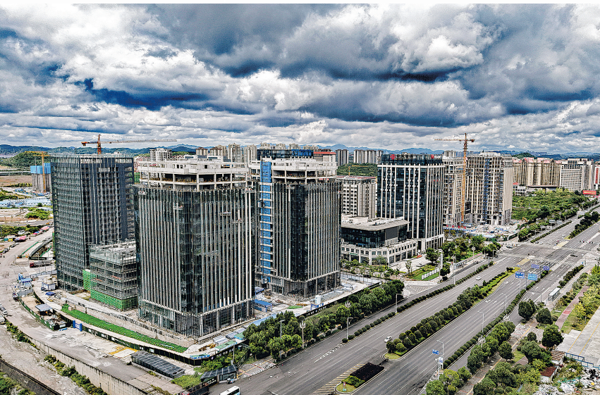
俯瞰建设中的科创城·数字经济港项目A区。
