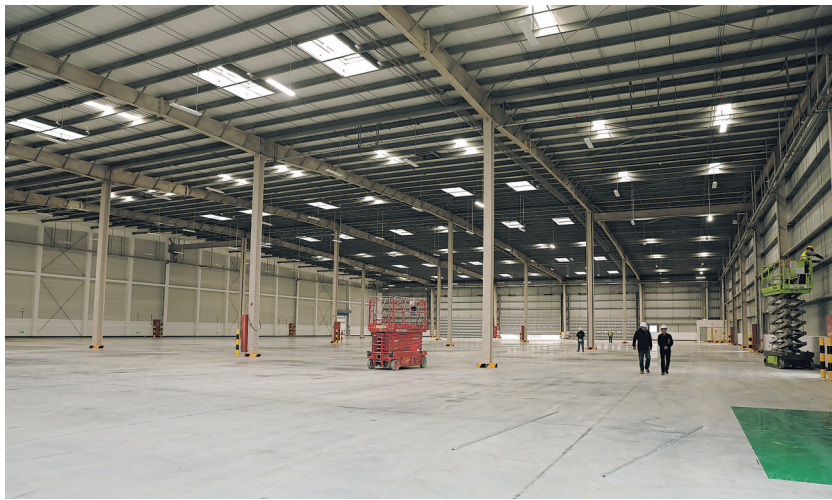
普黔铁路港项目二期B01、B03库房正在收尾。
