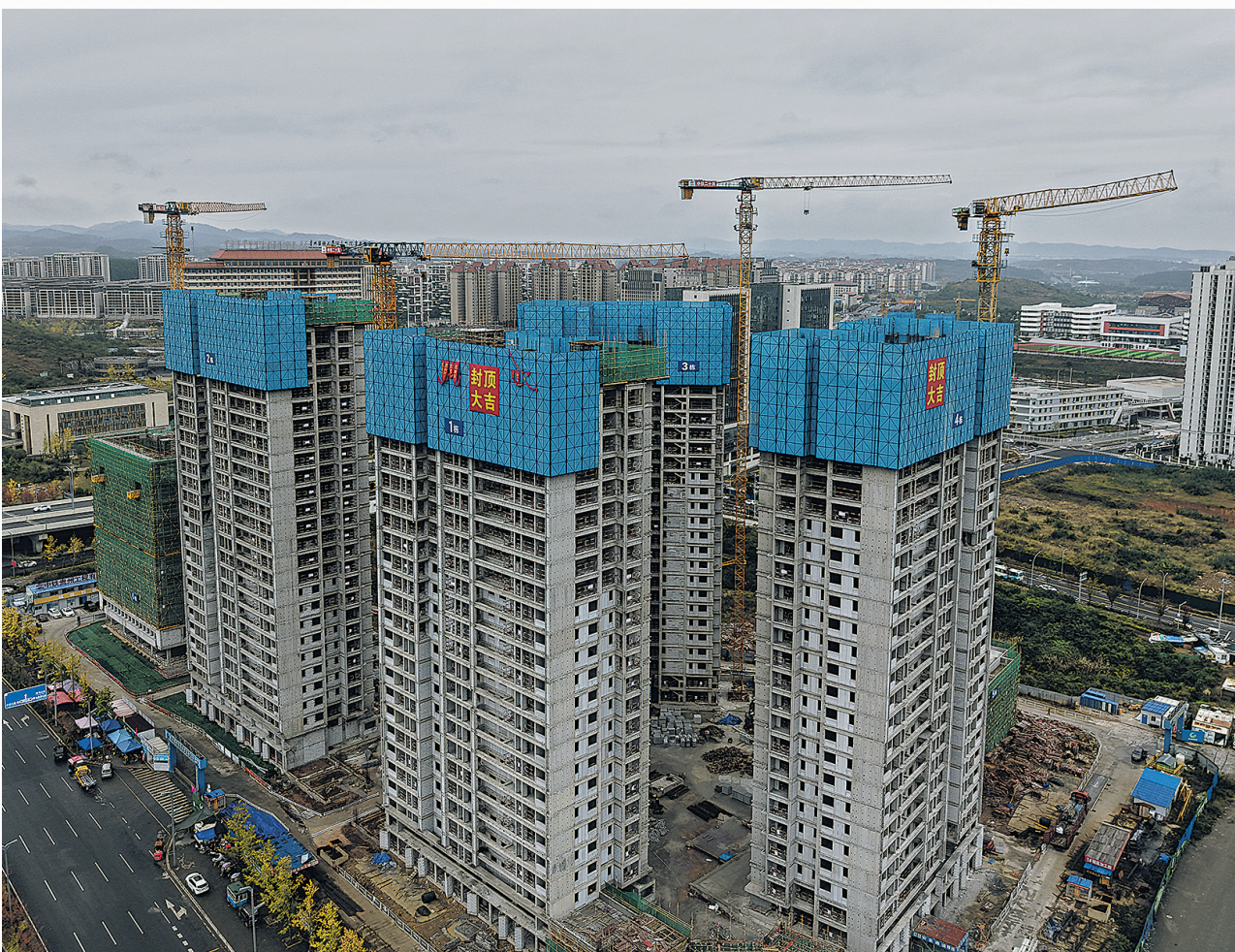
俯瞰已完成主体结构施工的贵安新区人工智能人才保障性租赁住房项目。
