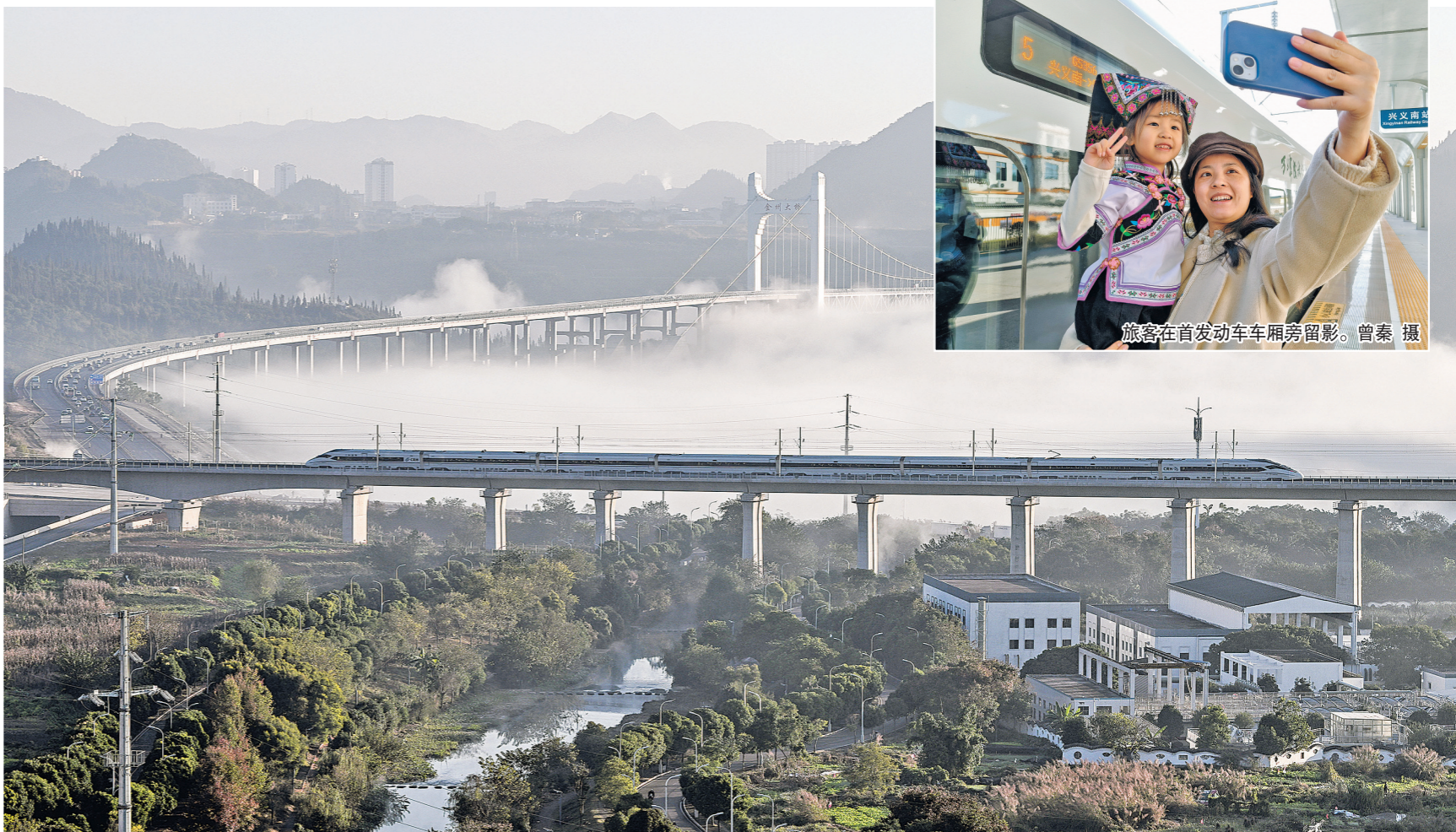
11月28日,一列动车组列车经过盘兴高铁北环线特大桥。新华社/传真
