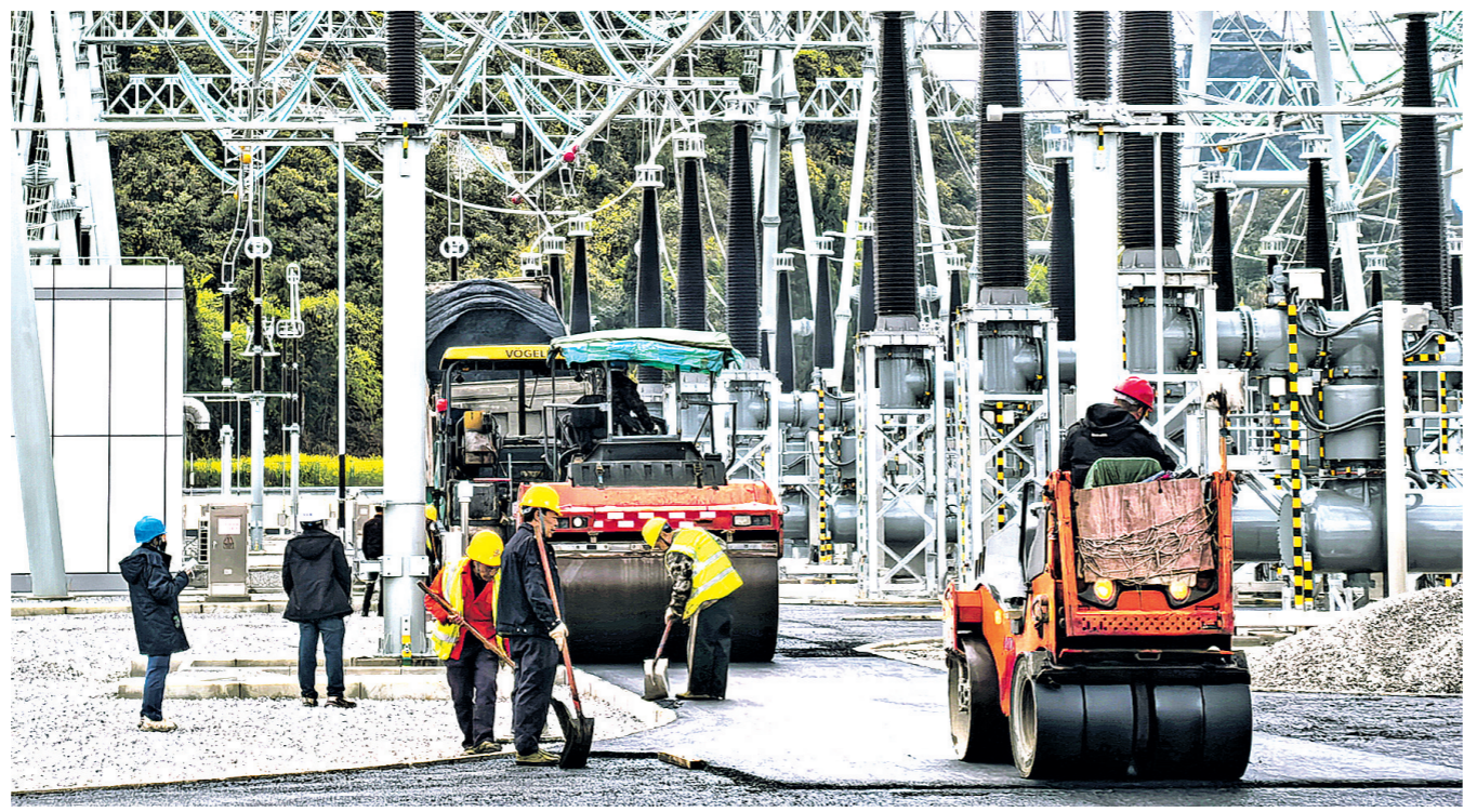
图为工人在500千伏马场变电站项目开展土建收尾工作。
