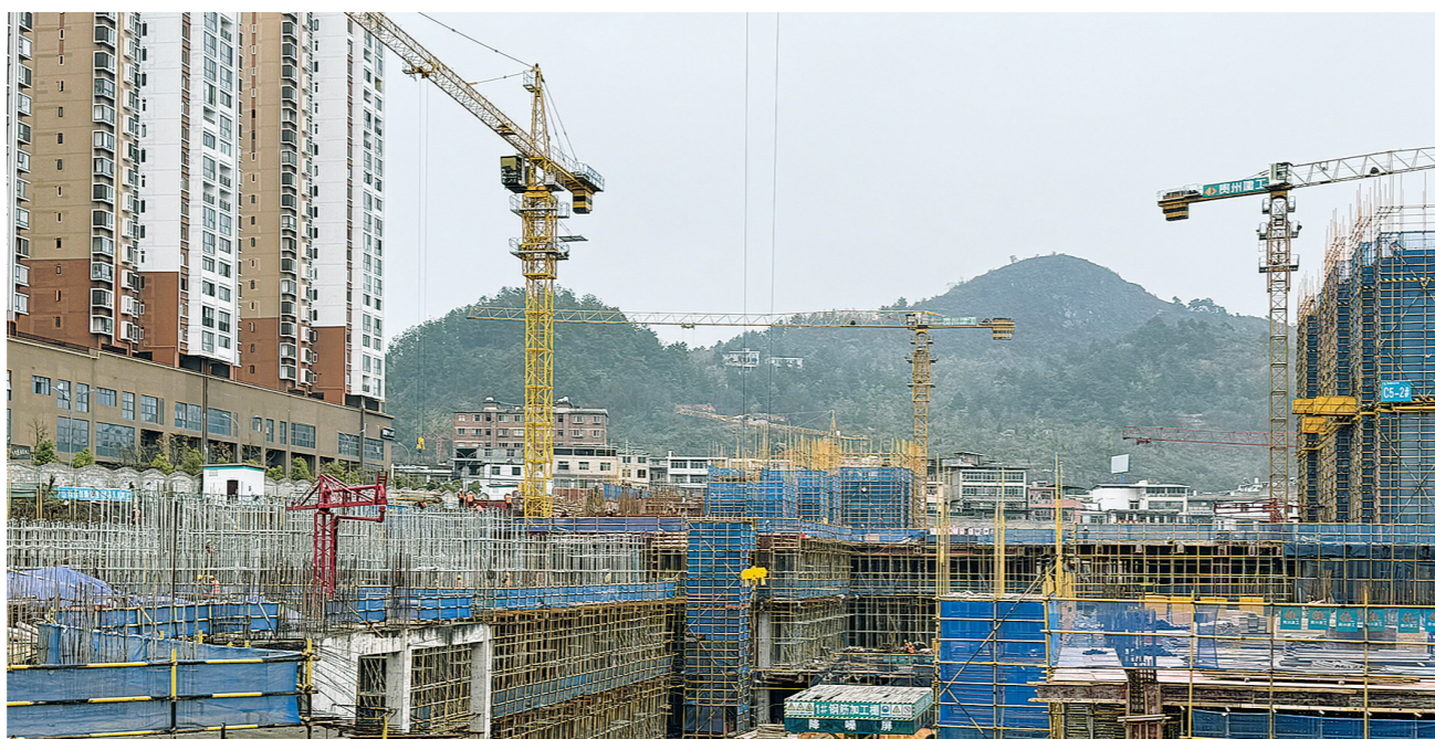
沙文城中村改造项目施工现场。
