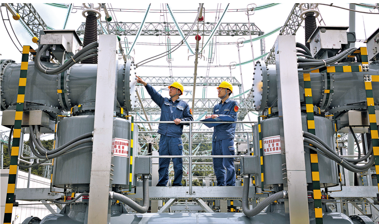
3月26日,技术人员排查500千伏马场变电站主变压器等核心设备状态,为正式投运做准备。
