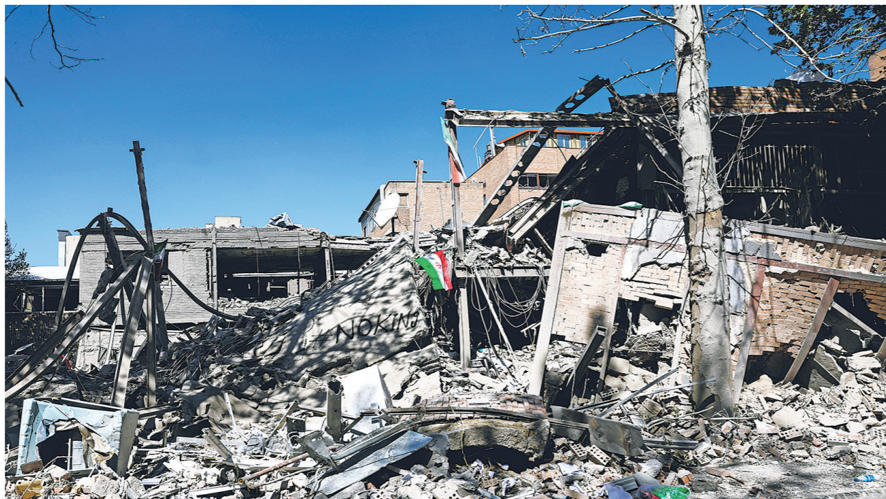
据《德黑兰时报》等多家伊朗媒体6日报道,美国和以色列对伊朗谢里夫理工大学实施了空袭。图为4月7日,在伊朗德黑兰的谢里夫理工大学,伊朗国旗挂在美以空袭后的废墟中。
