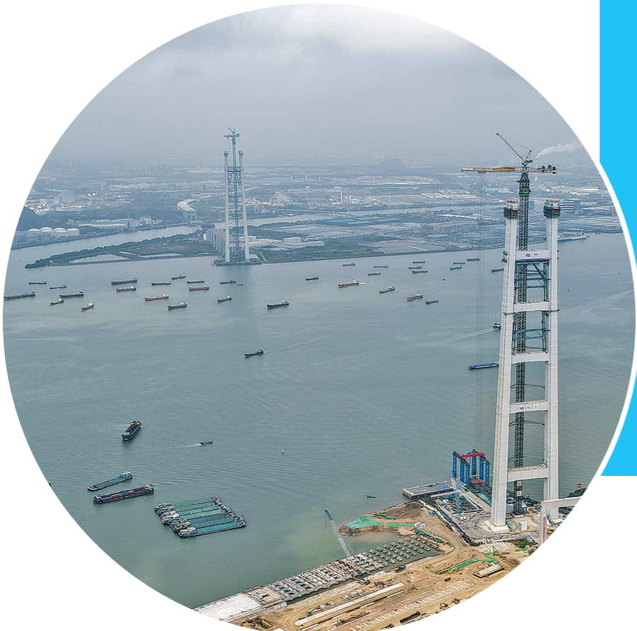
2026年3月26日拍摄的狮子洋大桥东、西主塔(无人机照片)。
