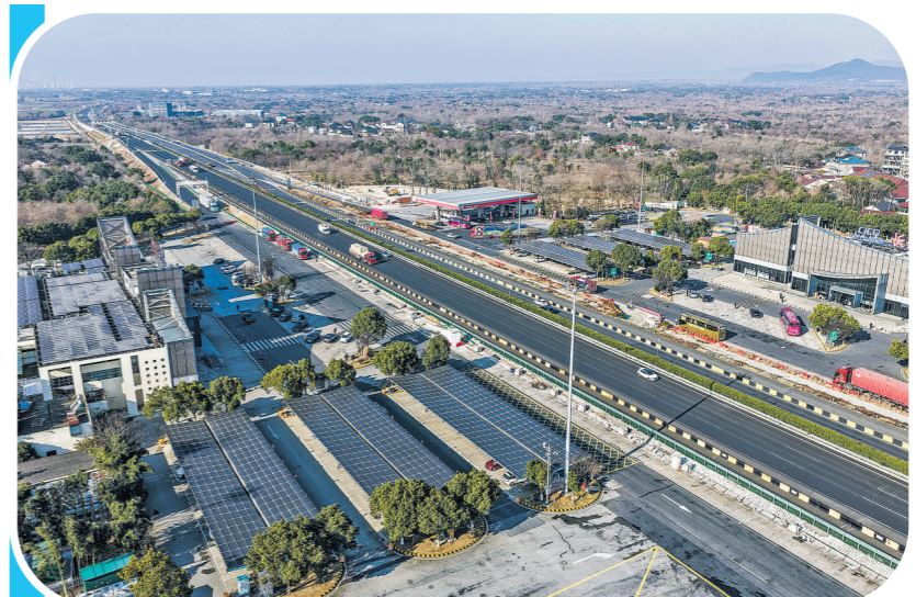
2026年1月7日拍摄的G50沪渝高速长兴服务区(无人机照片)。太阳能光伏板下是升级完成的高速服务区充电站。
