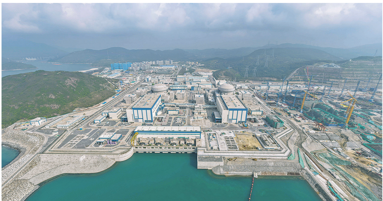
4月20日拍摄的中广核广东太平岭核电项目(无人照照片)。 新华/传真
