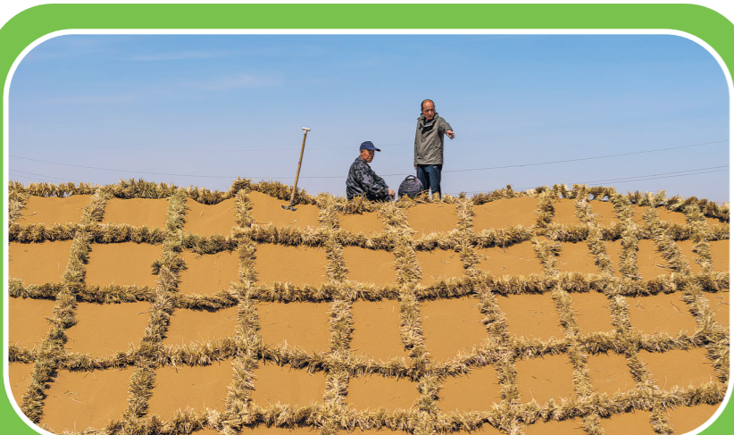
唐希明(右)在位于宁夏中卫境内的腾格里沙漠东南缘指导工人铺设刷状网绳式草方格(2026年4月10日摄)。
