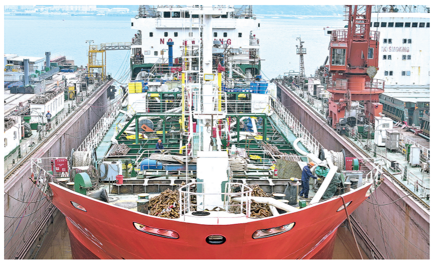
4月27日,在江苏省连云港鸿云实业有限公司生产基地,一艘船舶正在建设中(无人机照片)。
