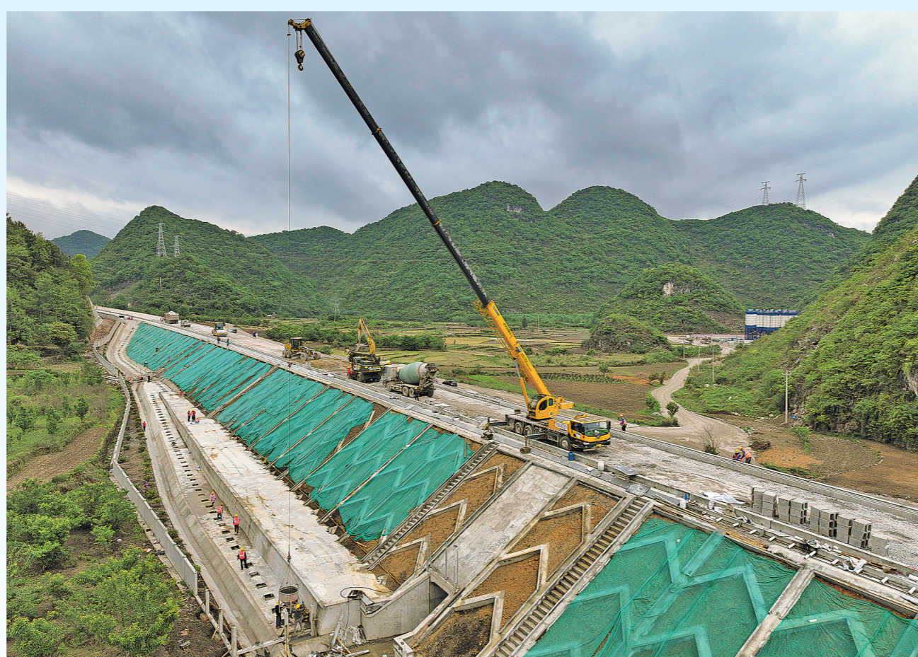
当前,位于贵州省镇宁县江龙镇境内的黄(桶)百(色)铁路贵州段站前二标段项目正在加紧建设。据了解,黄百铁路全长约315公里,设计时速160公里,为国家Ⅰ级单线电气化铁路,预计2028年建成通车。项目建成后,将进一步完善西部陆海新通道布局,构建我国西部地区通江达海便捷大通道。图为4月28日,中铁八局工作人员在进行路基施工作业(无人机照片)。 新华/传真
