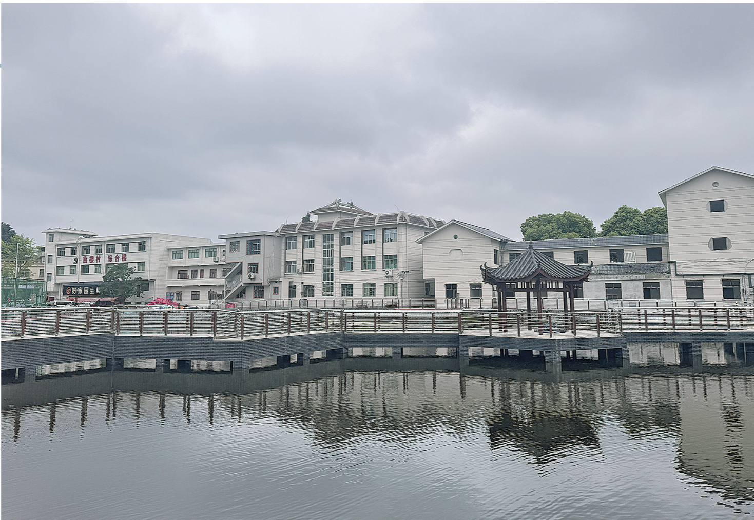
燕楼片区整治提升后的流动水系景观广场。
