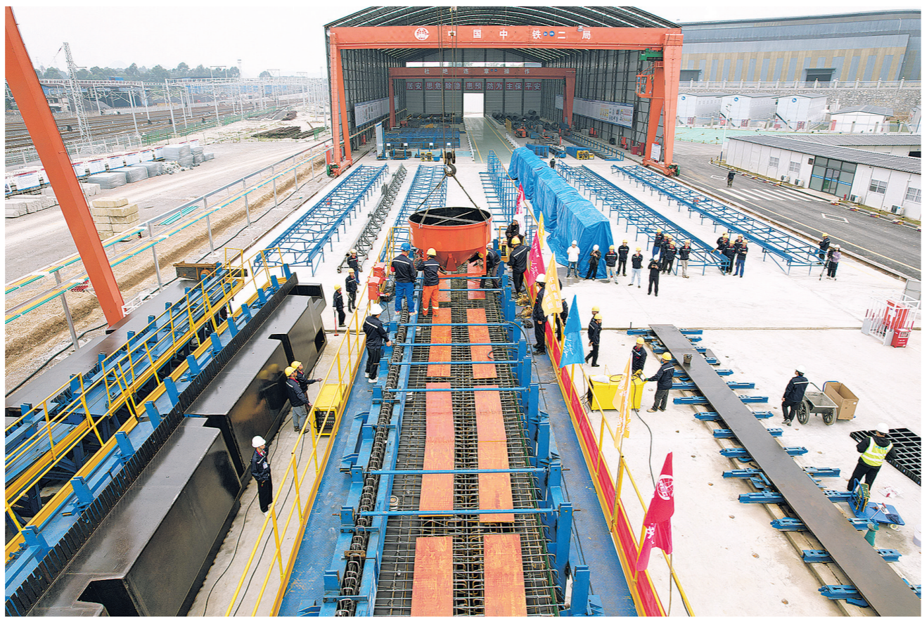
5月11日,工人在黄百铁路安顺制梁场准备浇筑首片T梁。
