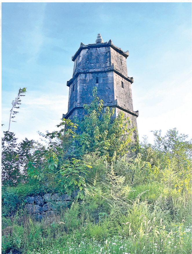
镇远县大地乡惜字塔。
