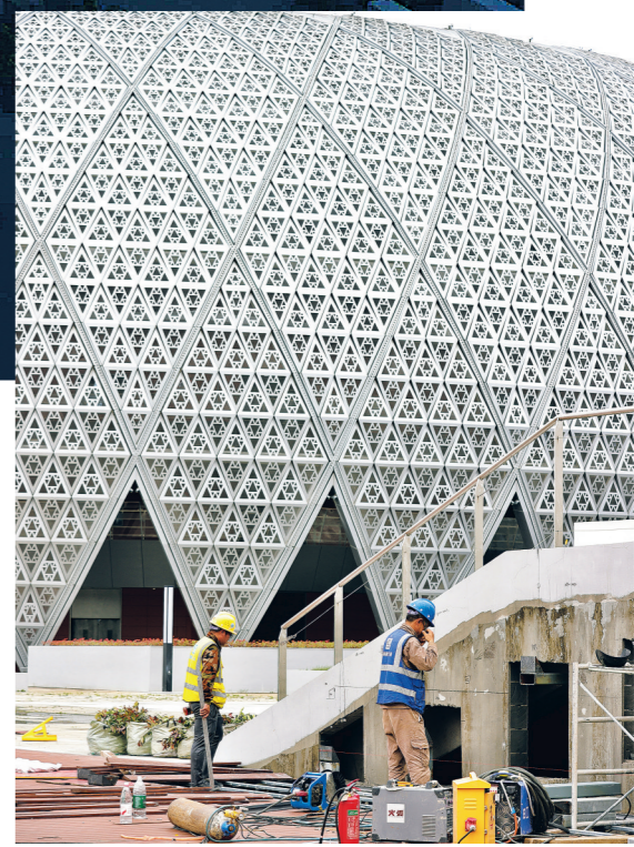
体育馆内，工人正在进行焊接作业。贵阳日报融媒体中心记者 张晨 摄
