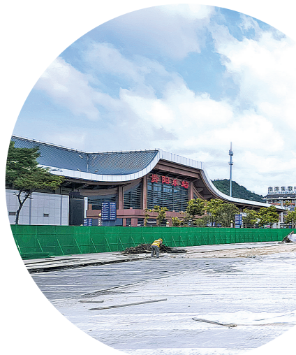
▲贵阳东车站前广场进站车道正在加紧建设。
