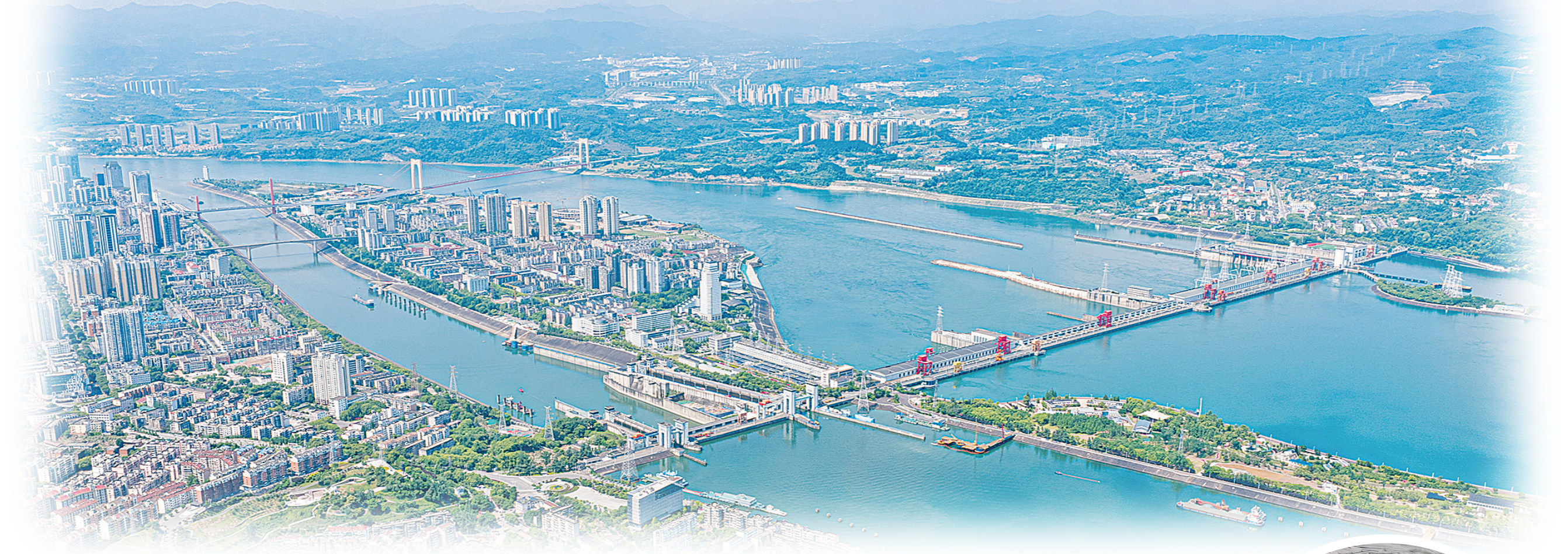
2026年5月14日,在湖北宜昌,船舶经过葛洲坝水利枢纽工程水域(无人机照片)。
