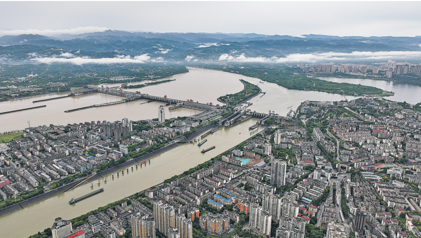
▲6月8日拍摄的三峡水运新通道工程葛洲坝航运扩能施工现场。
