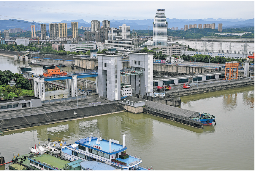
▼6月8日,船只经过葛洲坝三号船闸。
