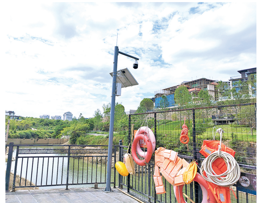
双龙航空港经济区在头堡河多彩贵州城段布设的一处监控设备。
